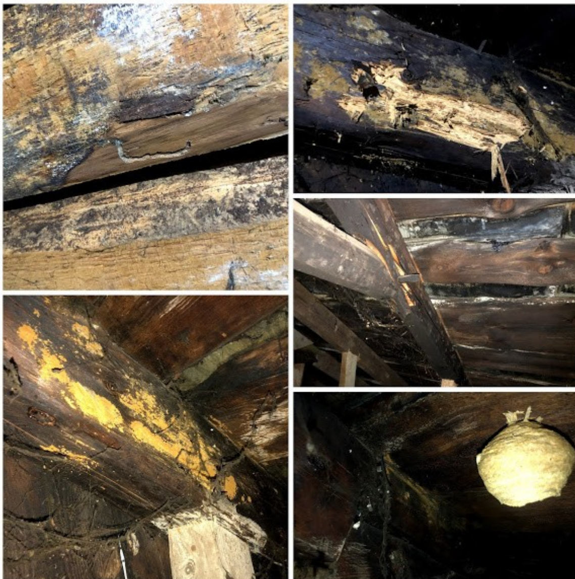
Fot. 17-21. Więźba dachowa i deskowanie – licznie występujące otwory wylotowe i żerowiska spuszczała pospolitego ( Hylotrupes bajulus ) i kołatka domowego ( Anobium punctatum ), widoczne zasuszone fragmenty grzybni grzyba domowego ( Serpula lacrymans ), rozkład brunatny drewna.
