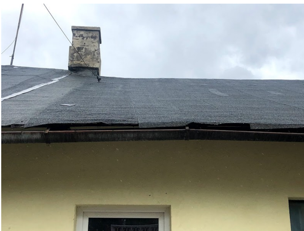
Fot. 9. Połącze dachowa – stan pokrycia papą.
