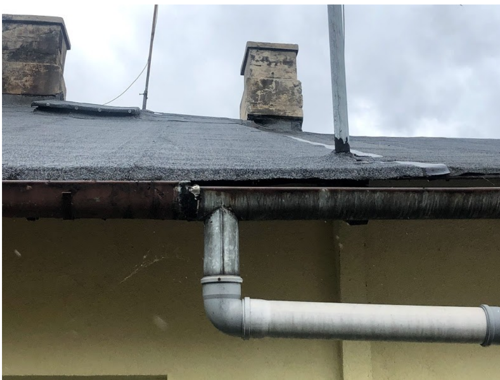
Fot. 8. Połącze dachowa – stan pokrycia papą.
