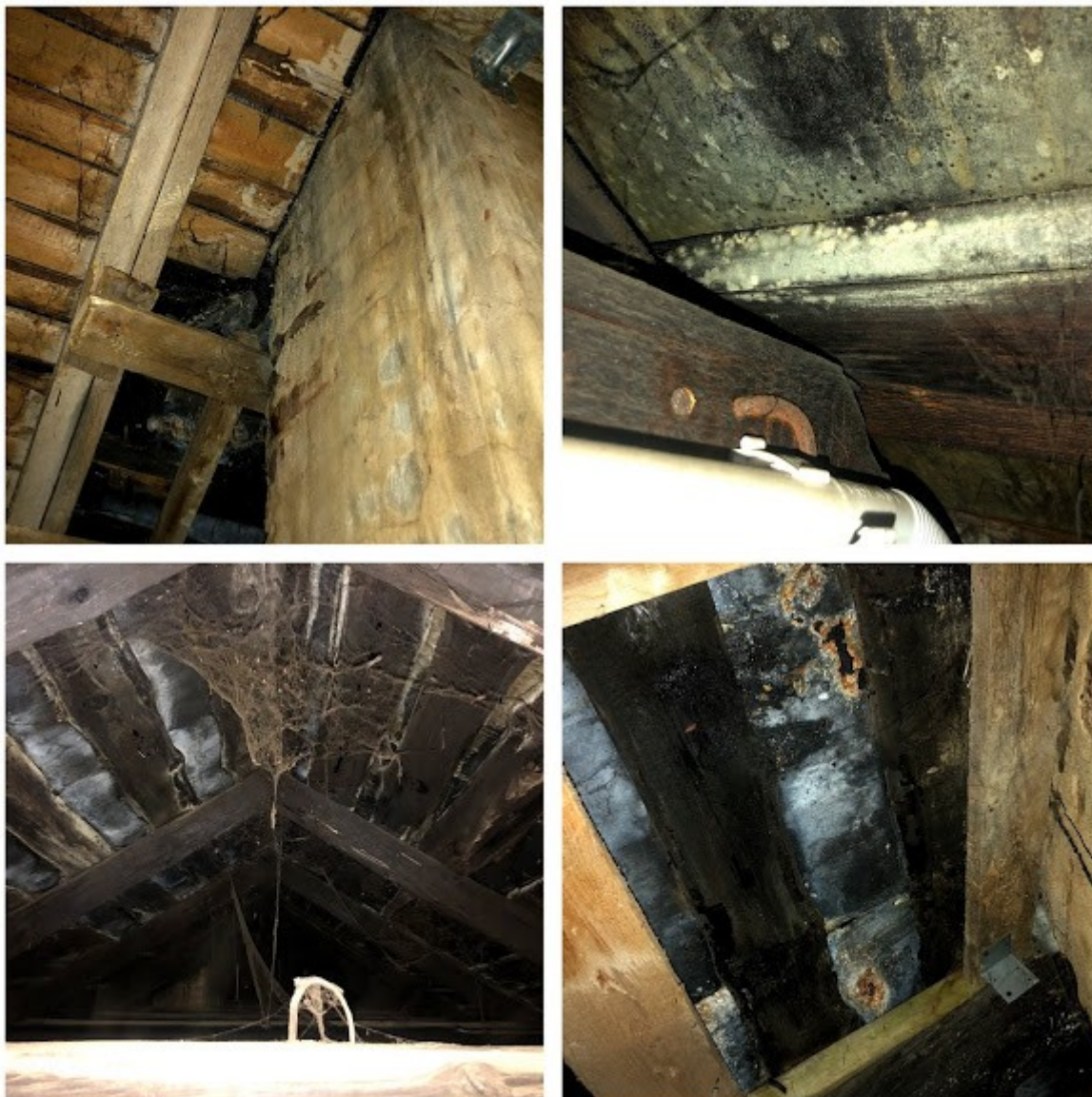
Fot. 13-16. Więźba dachowa część zachodnia - przeciekające pokrycie, oznaki częściowego zawilgocenia deskowania i krokwi, widoczne ślady porażenia grzybami pleśniowymi, postępująca korozja blachy.
