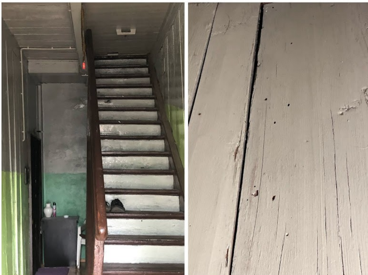
Fot. 22-23. Klatka schodowa -mimo ochronnej powłoki malarskiej występują otwory wylotowe kołatka domowego ( Anobium punctatum )
