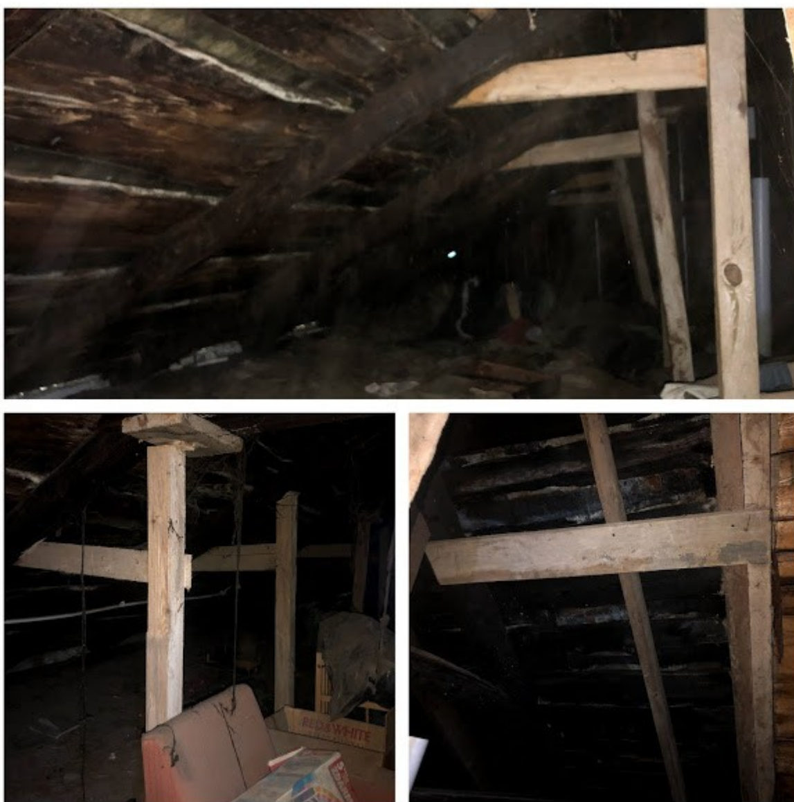
Fot. 10-12. Więźba dachowa część wschodnia – konstrukcje wzmacniające przegniłe krokwie, postępująca korozja biologiczna. destrukcja grzyba domowego ( Serpula lacrymans ), rozkład brunatny drewna.
