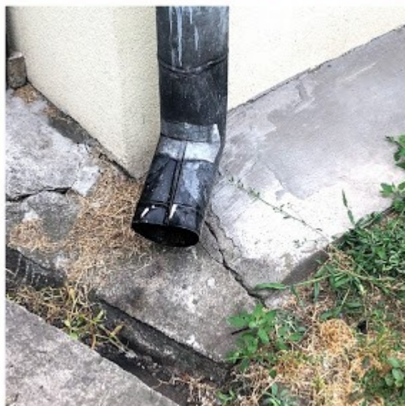
Fot. 4-7. Elewacje – uszkodzenia opasek betonowych, odprowadzenia wód opadowych do gruntu w bezpośrednim sąsiedztwie fundamentów
