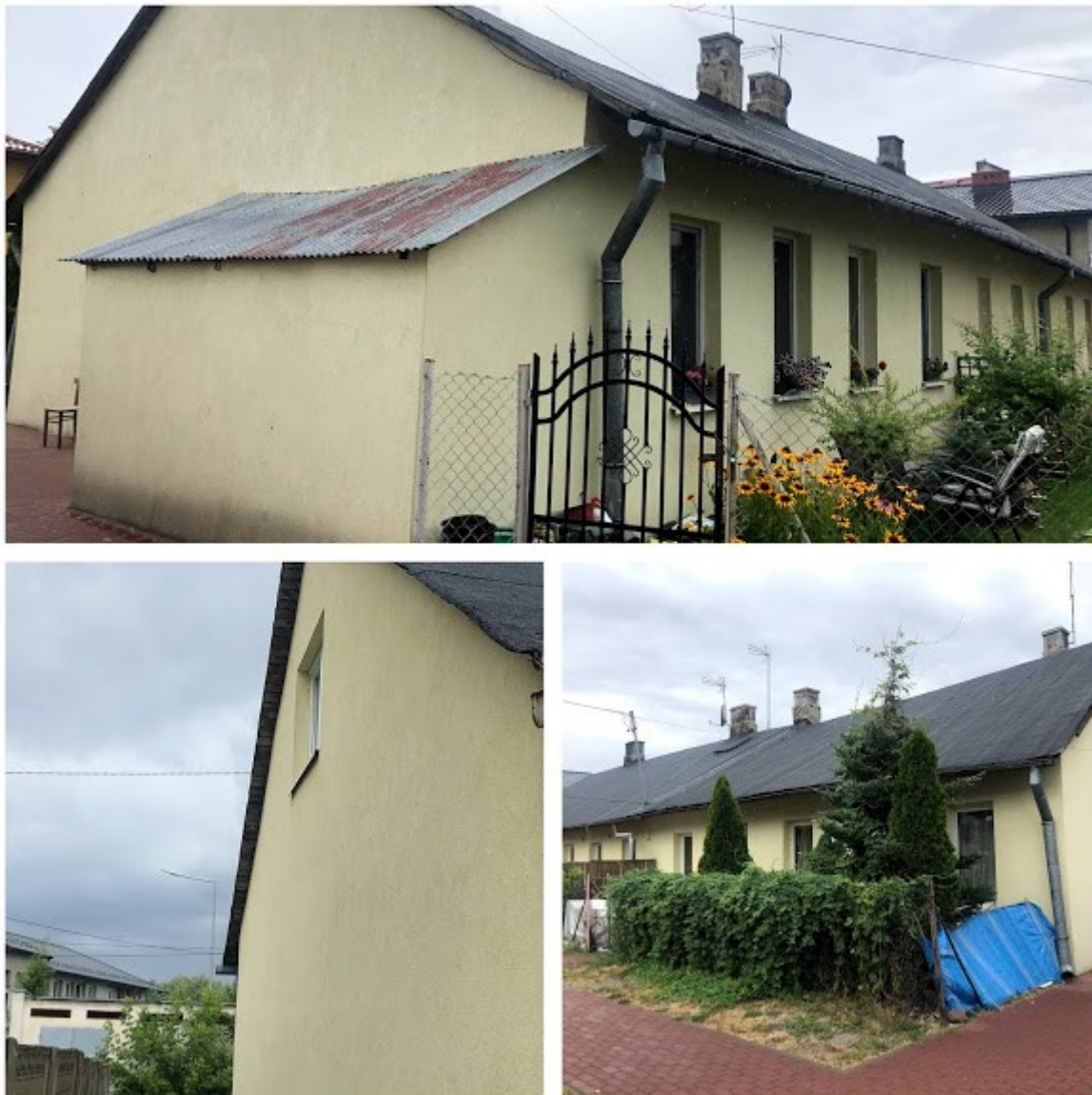
Fot. 1-3. Elewacje – stan i wygląd po ociepleniu – brak zewnętrznych uszkodzeń.
